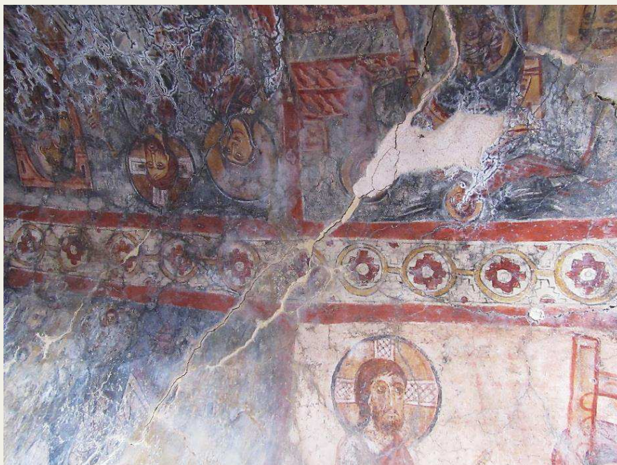
Η κατάγραφη καμαροειδής στέγη του εσωνάρθηκα
